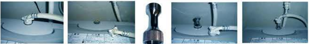
WashAAを取り付ける時は洗濯機側の樹脂ネジが壊れないように慎重に、丁寧に取付けてください。軽く回ります。
