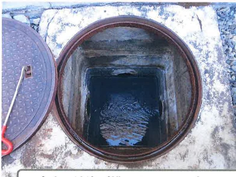
高水圧洗浄（排水管、排水柵）実施
