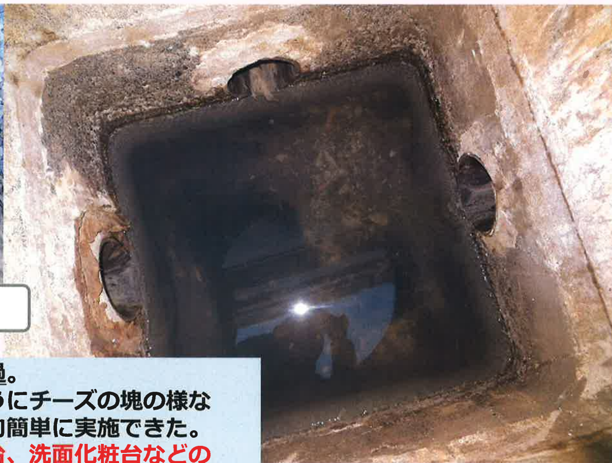
高水圧洗浄（排水管、排水柵）実施
